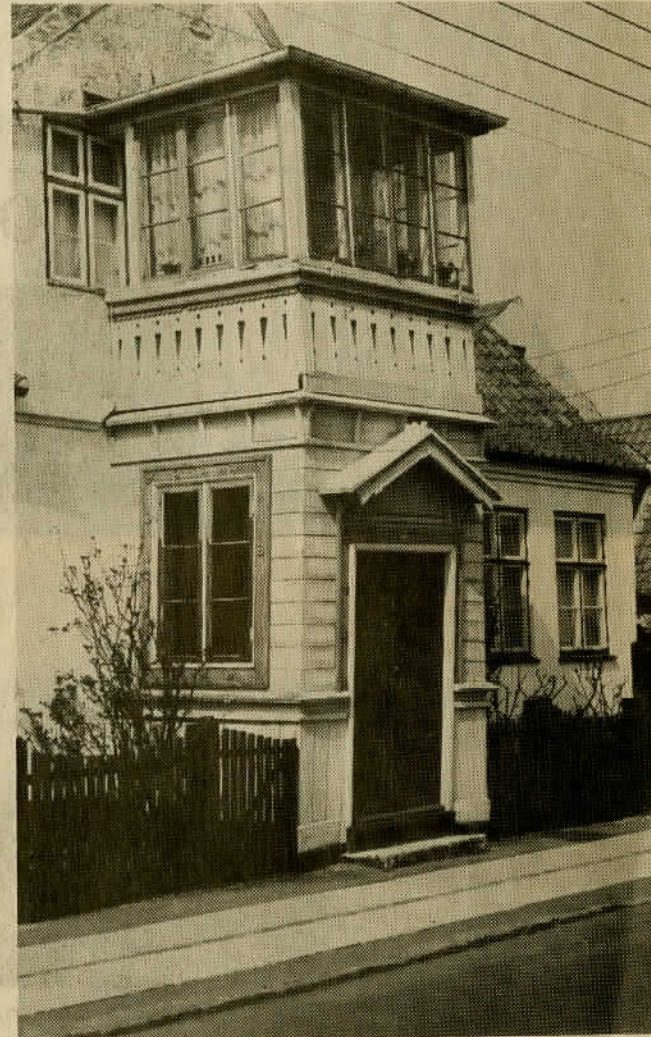
Strandlinien 49. Huset, der blev beskadiget under stormfloden i 1872. En stor, drivende pram tændte mod muren på nordsiden af indgangen. Beskadigelsen var tidligere synlig, men er nu helt udbedret. I 1872 boede lods Jørgen Hendrik Palm i huset.
